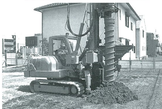
①標準工法では土砂を排出
