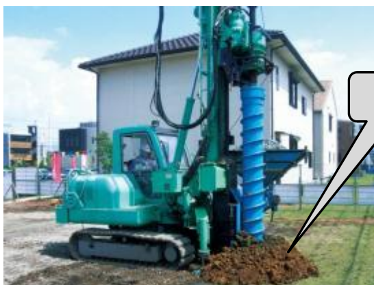
【現状】土砂が排出される。
