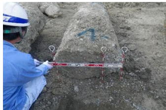
写真4 柱状4の杭径検測
