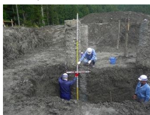
写真 2 柱状 2 杭径検測 (GL-2m 地点)
