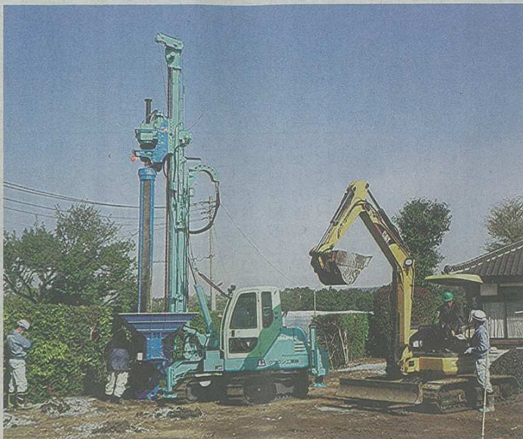
エコジオ工法を用いて地盤を補強している様子＝尾鍋組提供
