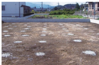
施工後の地盤（住宅）
