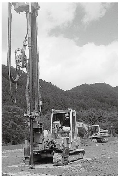
その場合に、回転力が強すぎると杭を破損させる場合があるため、注意が必要です。また、施工角度が地盤面と鉛直になるように施工することも重要です。
