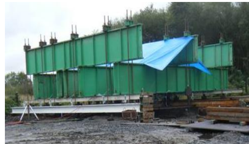
写真-2 載荷試験実施状況 (千葉県野田市)
