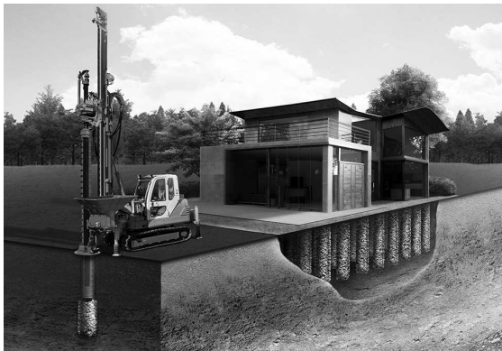
第1図 エコジオ工法の施工イメージ
