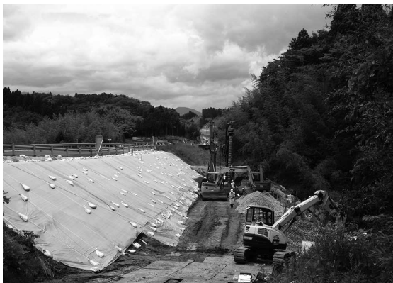
第7図 高速道路での盛土排水対策
