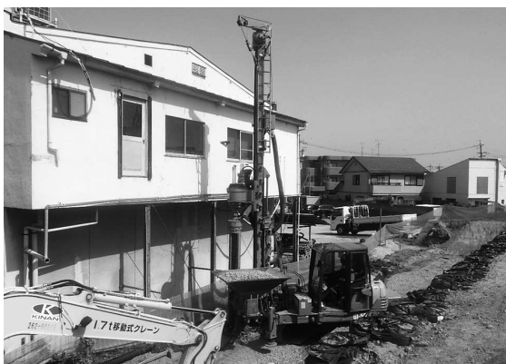
第3図 狭い現場での施工状況
