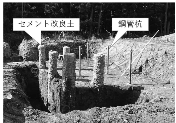
第8図 セメントで固めた土、鋼管を掘り起こした様子
