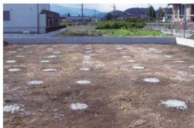
施工後の地盤（住宅）
