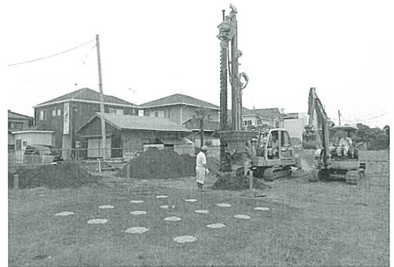
写真6 試験施工状況
