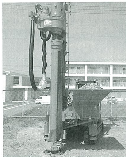
写真5 非排土タイプのエコジオ工法
