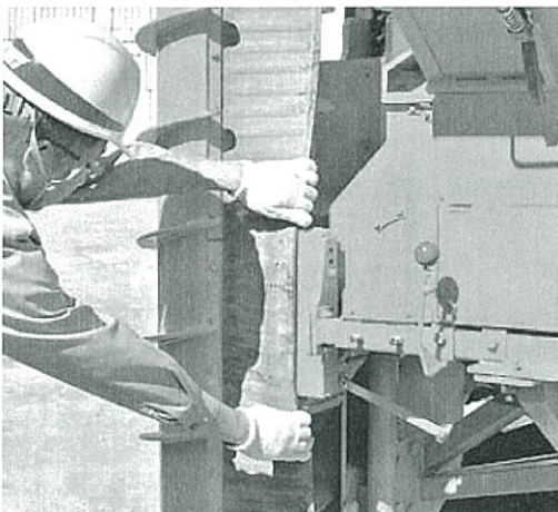
写真3 ケーシングパイプの碎石投入用ゴム扉
